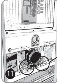
Gömme rezervuar sıcak - soğuk su bağlantılarının klozet bağlantısına uygun olması için tesisatın klozete uyumlu olması önemlidir. Klozete tesisatınızın uyum kontrolünü kesinlikle yapınız, yapılmadığı takdirde montajınız olmayacaktır.
